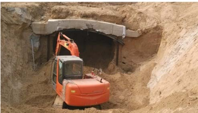
图9 在预衬砌结构保护下模拟隧道开挖。
